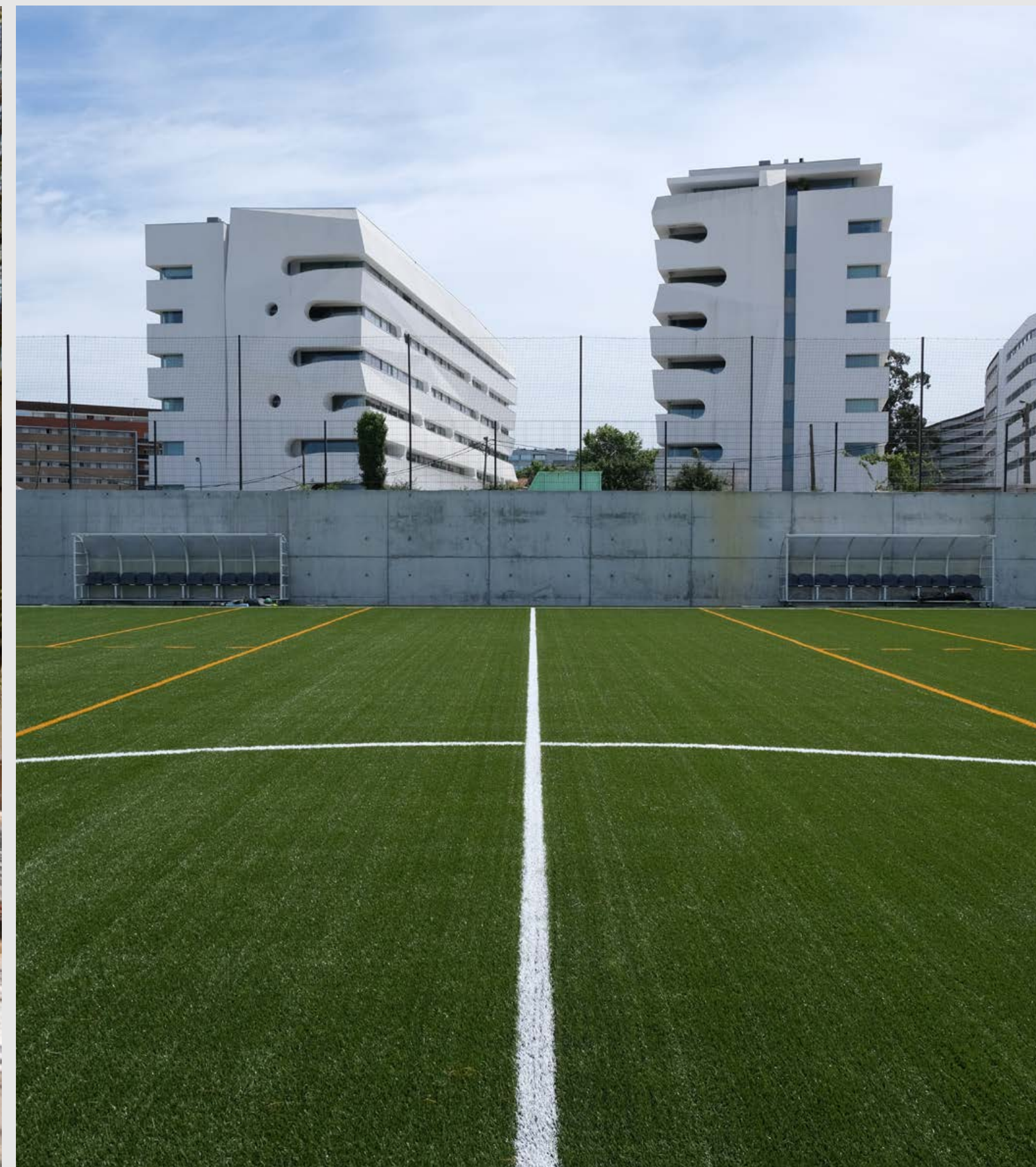
Construção do Campo do Outeiro Instalações desportivas
