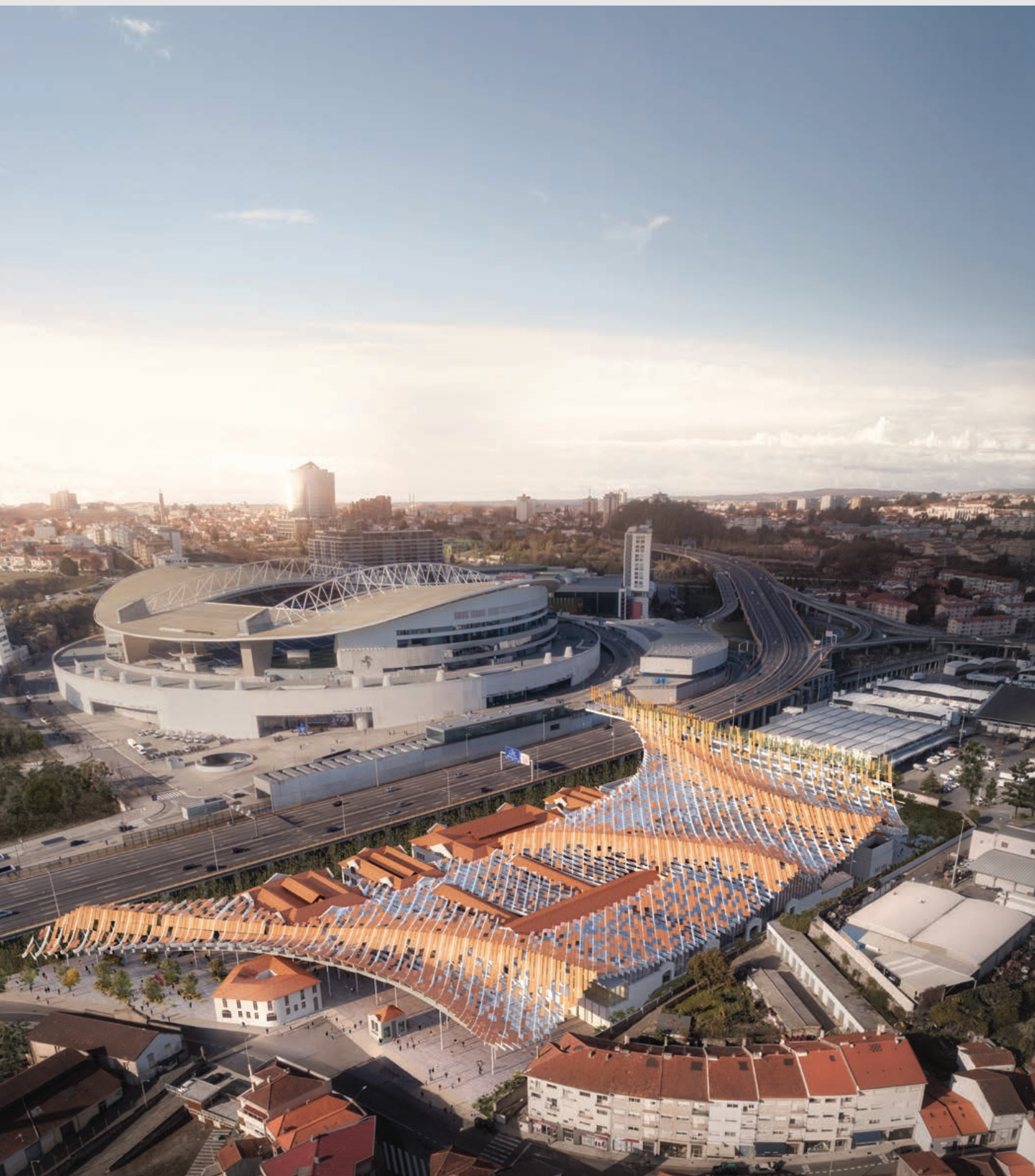
Reconversão do Antigo Matadouro Industrial do Porto
