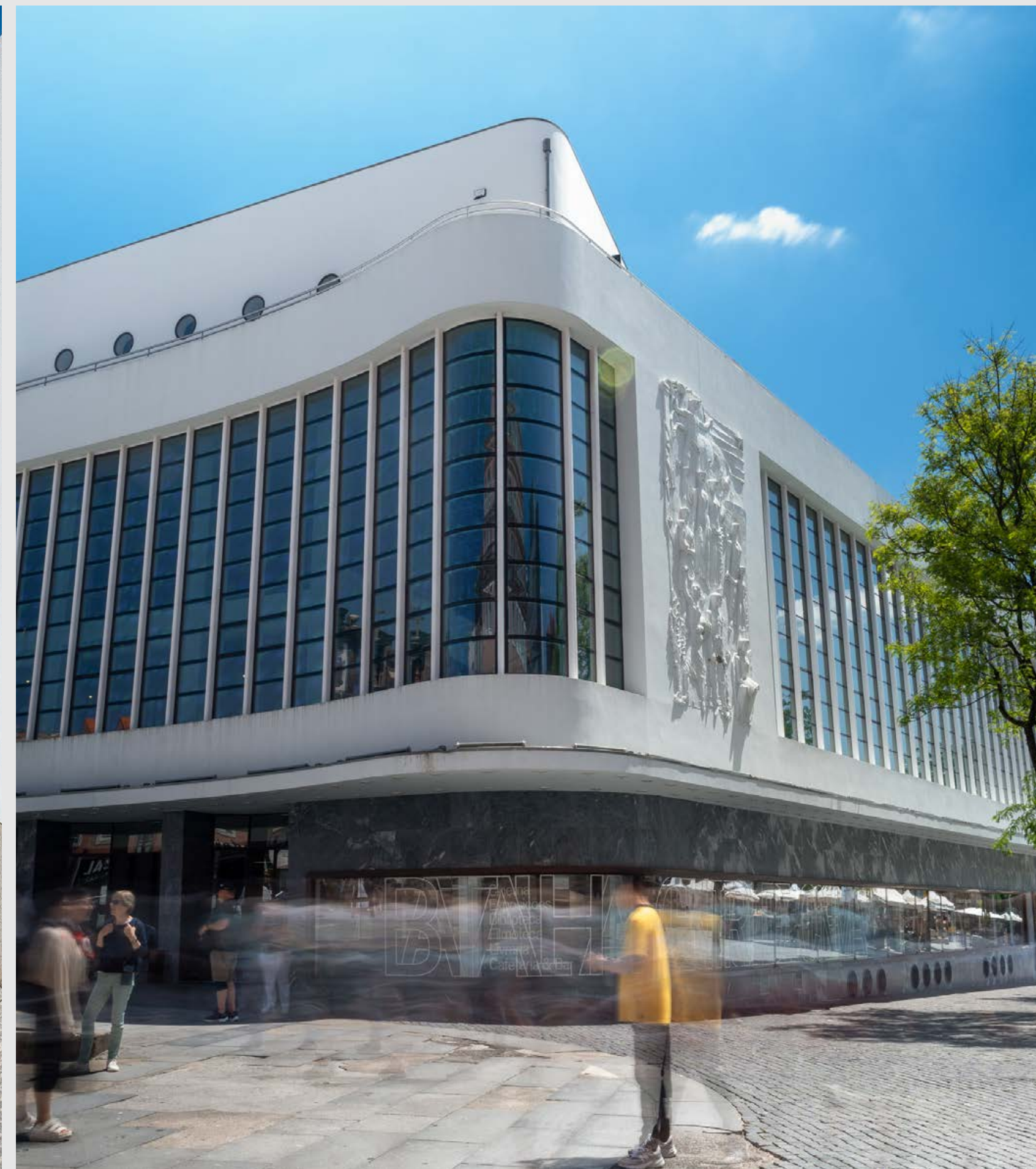
Reabilitação do Cinema Batalha
