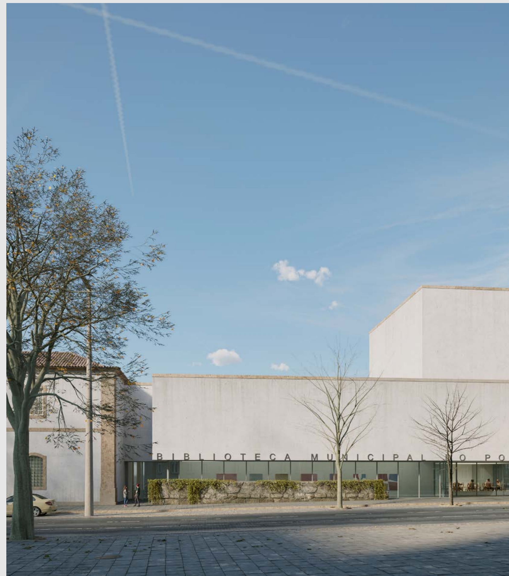
Reabilitação da Biblioteca Pública Municipal do Porto
